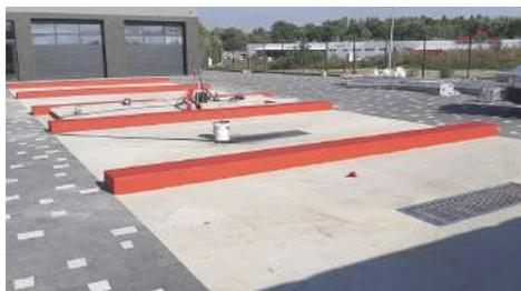
Стандартное решение для автомоечноо комплекса это бетонная плита толщиной 200мм. с двойным армированием и теплым полом.
